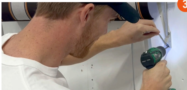
Skruva fast bandlåset till väggen.
